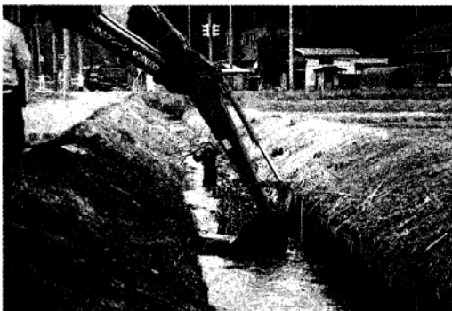
排水路の浚渫状況
