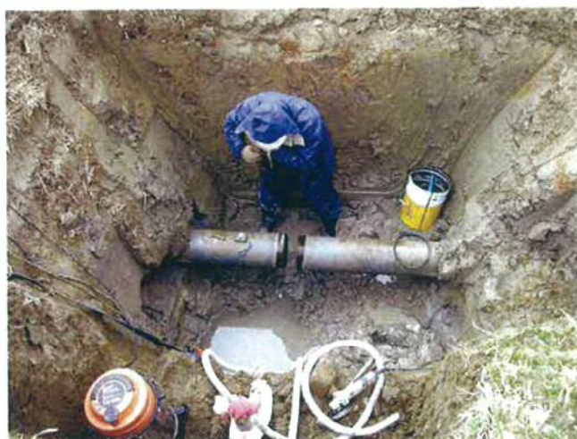
パイプラインの補修
