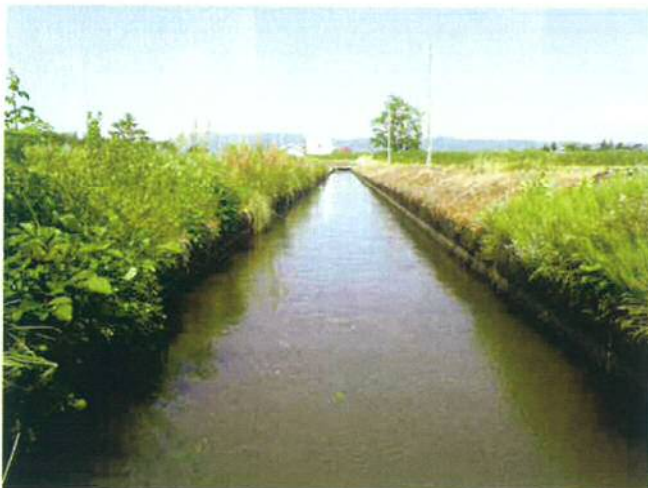
現在の頭首工からの幹線用水路
