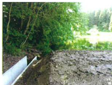
余水吐の補修
