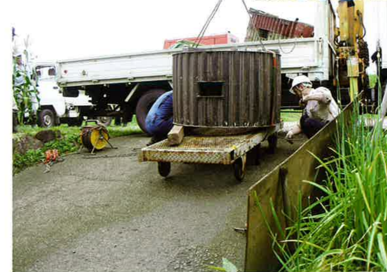
液体抵抗器の代替品設置
