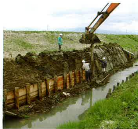
排水路の補修活動
