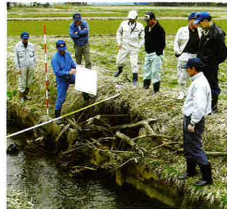
排水路の点検
