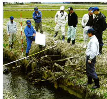
排水路の点検
